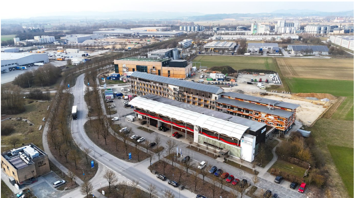
Der Scale-up-Hub in Straubing wächst: TGZ-Erweiterung (vorne) und BioCampus MultiPilot (dahinter)
