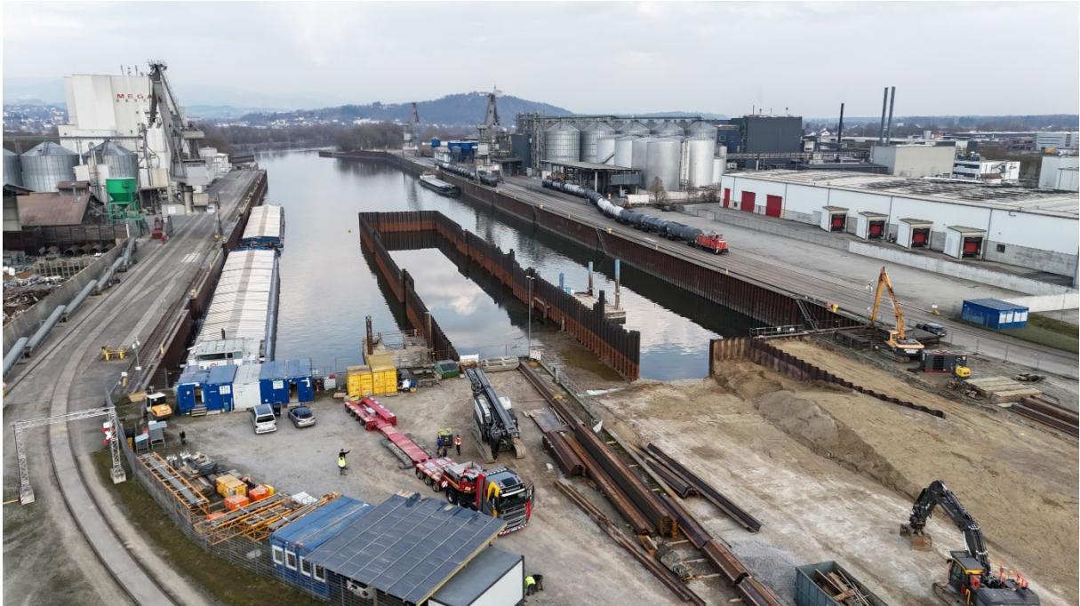
Neue Möglichkeiten für den Umschlag sperriger und schwerer Güter: das High&Heavy-Terminal im Hafen Straubing-Sand
