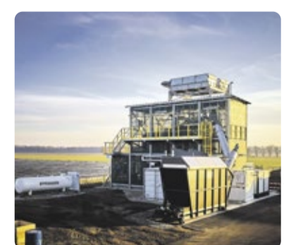
Demonanlage der LXP Group in Aholting im Landkreis Straubing
